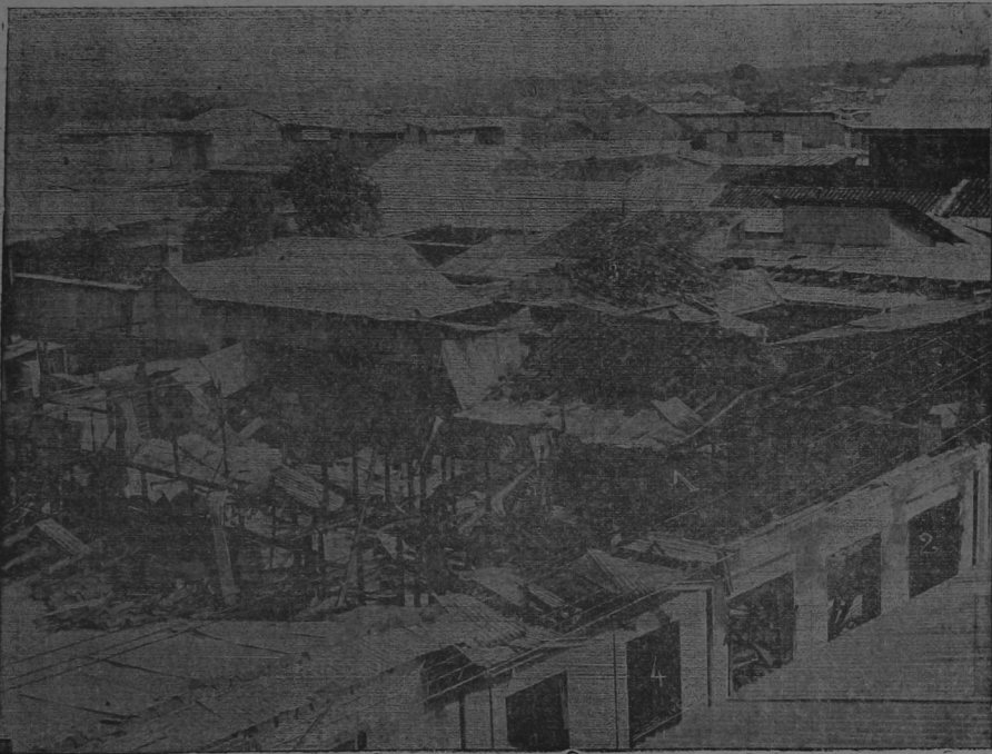
Destrozos ocasionados por el incendio de anoche
